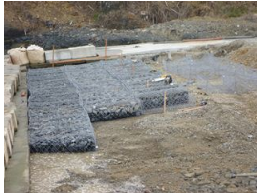
(船着場の基礎部分)
