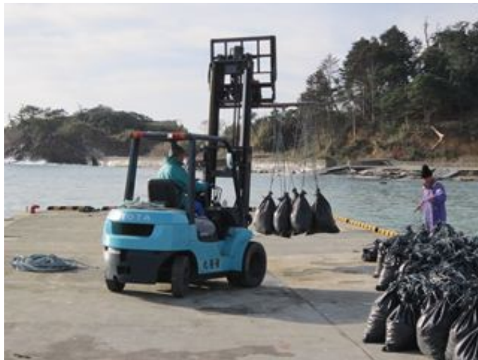
(作った土俵を沈める様子)
